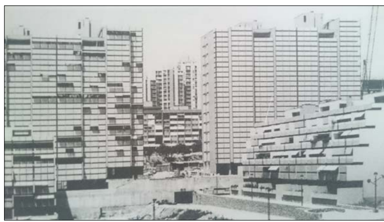
4. Ulica Borisa Papandopula dio urb. koncepta Splita 3, najzapaženija zbog oblikovnog i funkcionalnog tretmana pročelja. Nudi optimalno rješenje lode koja postaje vanjskim dijelom stana. NAMJENA: stambena PROJEKT: Ivo Radić, "Projektna grupa Split 3" Split
