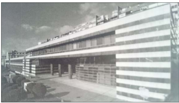
6. Poslovna zgrada Brodomerur U prostornom kontekstu glavnog ulaza u grad, na vrlo izloženoj i značajnoj lokaciji komercijalno-poslovna zgrada se uklapa u urb. matricu Splita 3 afirmirajući pješačke tokove autor vješto rješava međudodnos sa stambenom zgradom Frane Gotovca u pozadini. NAMJENA: poslovna PROJEKT: Danko Colnago, "Lavčević" Split
